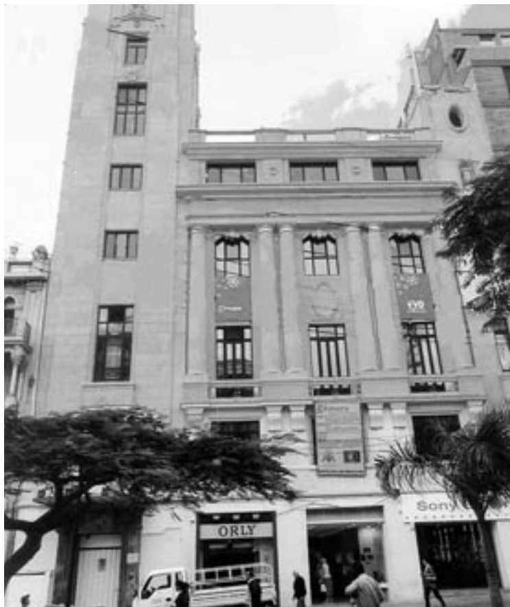
El edificio de la entidad cameral está siendo objeto de unas obras que, en breve, quedarán finalizadas. / EL DÍA
